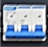
DIPA100 | <ul style="list-style-type: none"><li>• Leistungsschalter:<br/>Schaltet bei zu hohen Strömen die Maschine ab</li></ul>                        |
